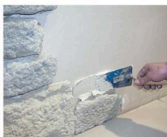
FASE 2 Applicare il collante con una comune spatola sulla parete da rivestire
