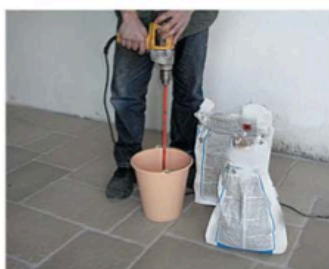
FASE 1 Preparazione del collante.
