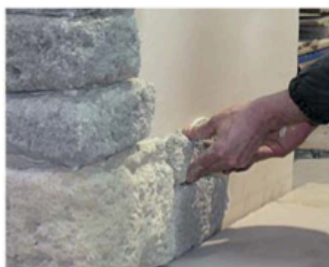
FASE 4 Fare pressione sulla parete spostando la tavella da destra a sinistra e dall'alto verso il basso
