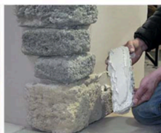
FASE 3 Applicare il collante sulla tavella da posare
